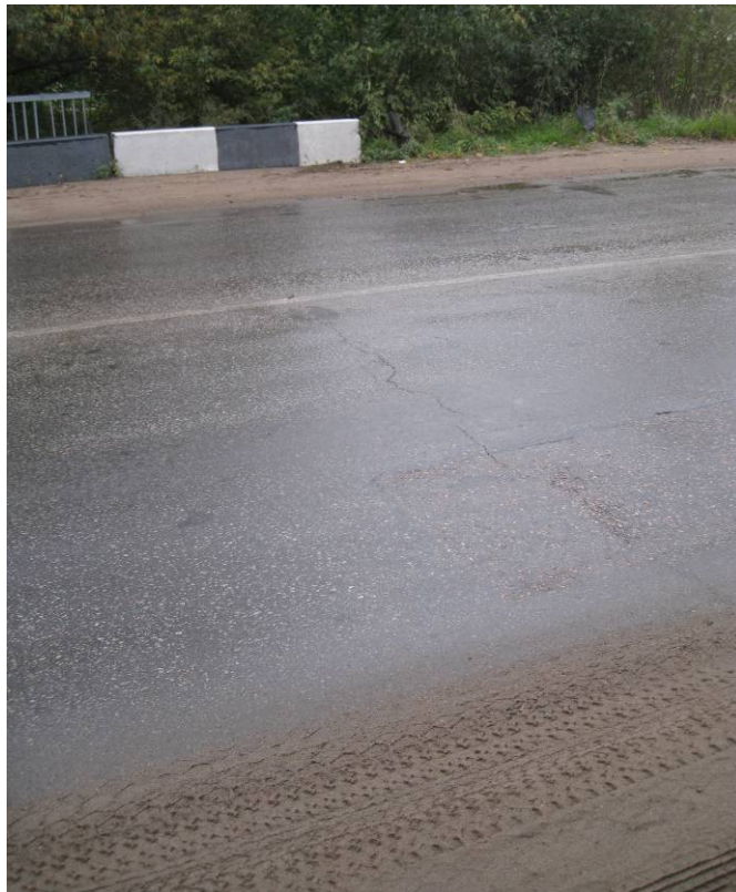
Рисунок 5. Трещина в зоне деформационного шва над опорой №1, вид с левой стороны
